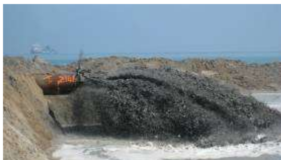
Figura IV.2.3.4.1- ripascimento con sabbie sottomarine
