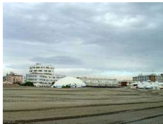
Figura IV.2.3.1.5- esempio di argine di protezione invernale correttamente eseguito
