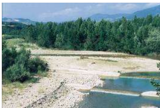
Figura IV.2.3.4.7- esempio di materassi di sovralluvionamento in corrispondenza di opere
