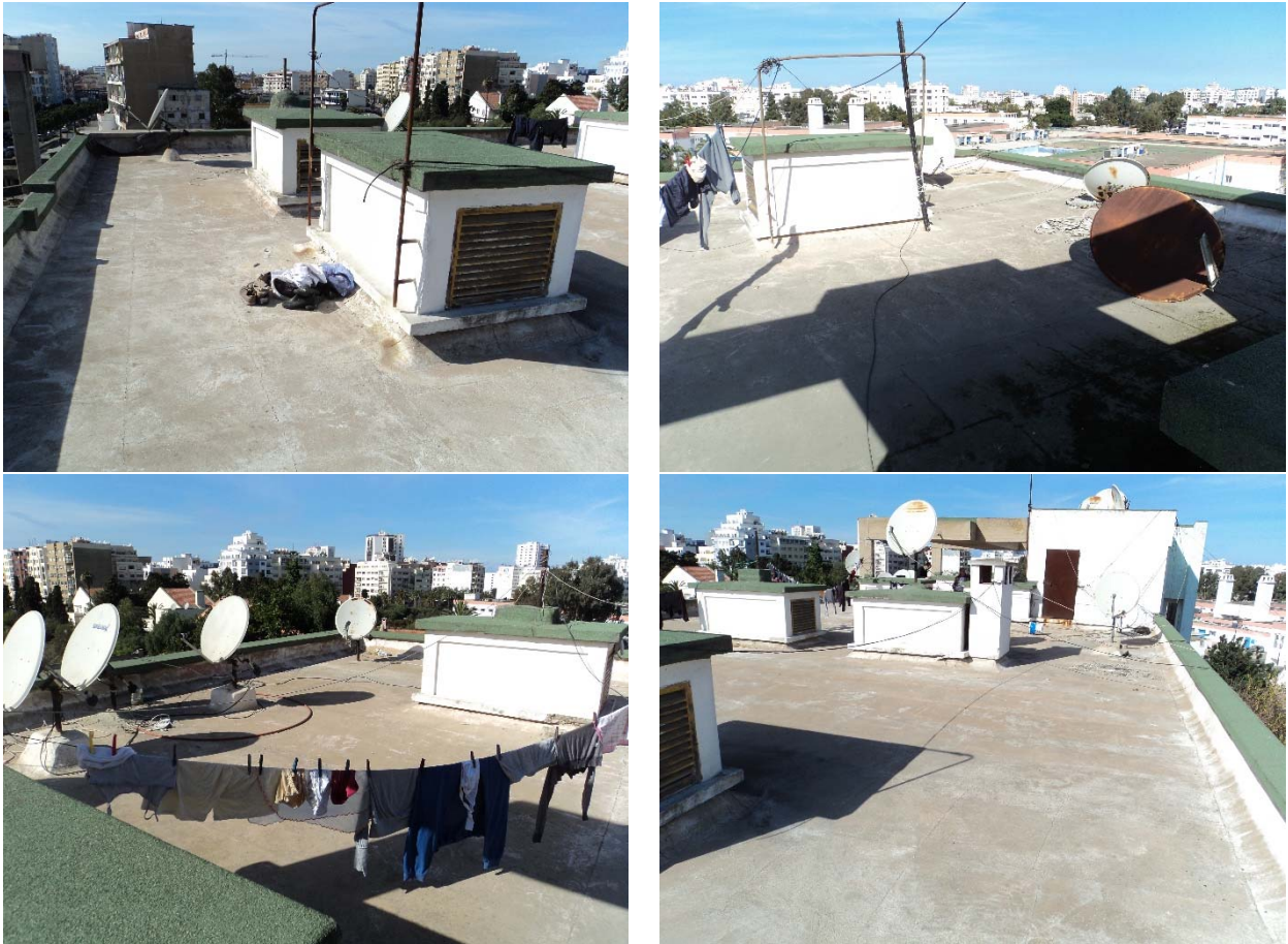
Figura 0.2: Foto copertura edificio.
