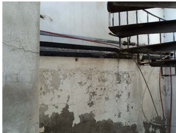
Figura 0.3: Tubo di distribuzione, tratto esterno.
