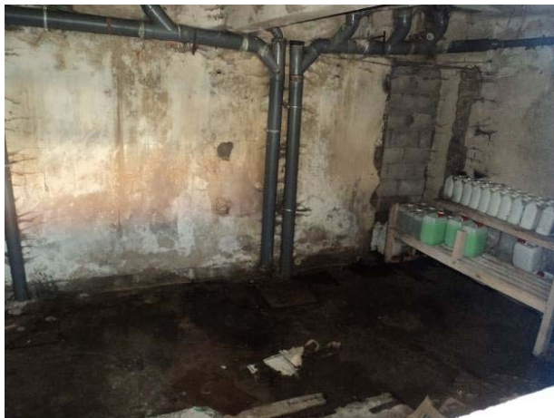
Figura 0.6: Esempio di locale seminterrato, fotografia da piano strada.
