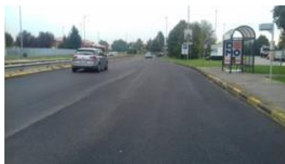
Figura 2 – Nuova pavimentazione a bassa rumorosità su Viale della Libertà (foto: staff LIFE MONZA)
