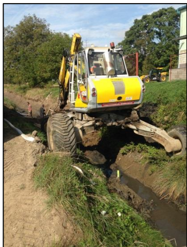
Foto 2 – Attività di dragaggio dei sedimenti per l'avvio della prova di co-compostaggio in Repubblica Ceca (Fonte: LIFE Agrised)
