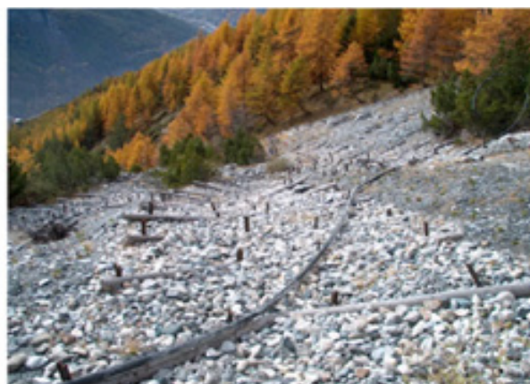
Foto 3-4. Interventi di manutenzione del reticolo delle acque
