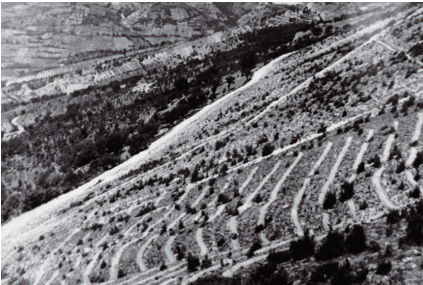
Foto 11 - Esempio di gradonamento e preparazione del terreno in un intervento di rimboschimento realizzato a metà del secolo scorso presso Poggio Bustone, in provincia di Rieti (foto: G. Occhietti).
