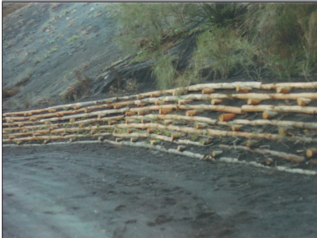
Figura 6 - Parco Nazionale del Vesuvio, Campania. Opera di ingegneria naturalistica costituita da una palificata doppia, in materiale morto e vivo, per stabilizzare il piede del versante ed evitare frane e smottamenti.
