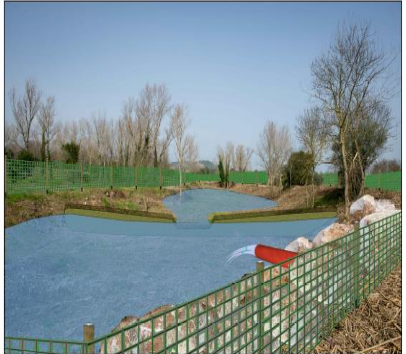
RENDERING VASCA DI SEDIMENTAZIONE E INFILTRAZIONE
