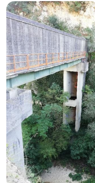
Attraversamento f. Farfa (pontetubo)
