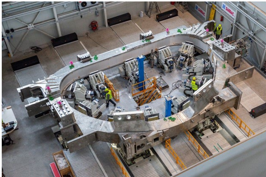
Figura 9. Inserimento delle 10 bobine del magnete toroidale di ITER nelle strutture metalliche di contenimento presso SIMIC (Marghera, Venezia).
